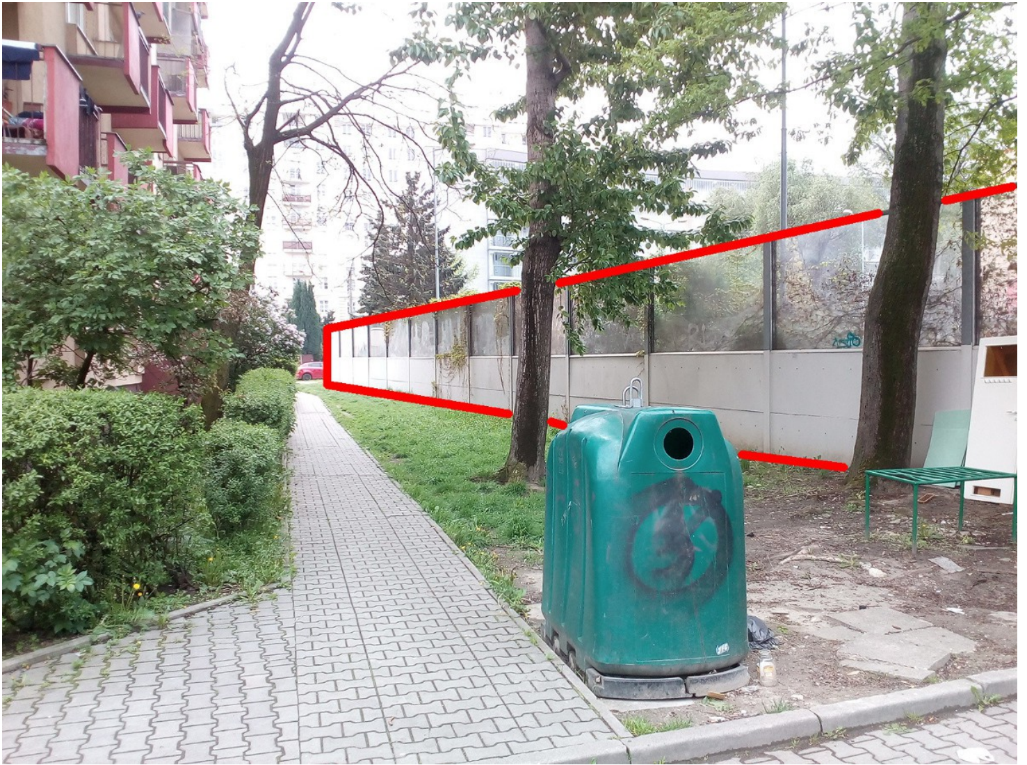
Mur oddzielający działkę od parkingu Kaufland
