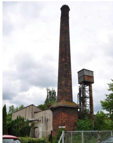
Kotłownia z kominem
