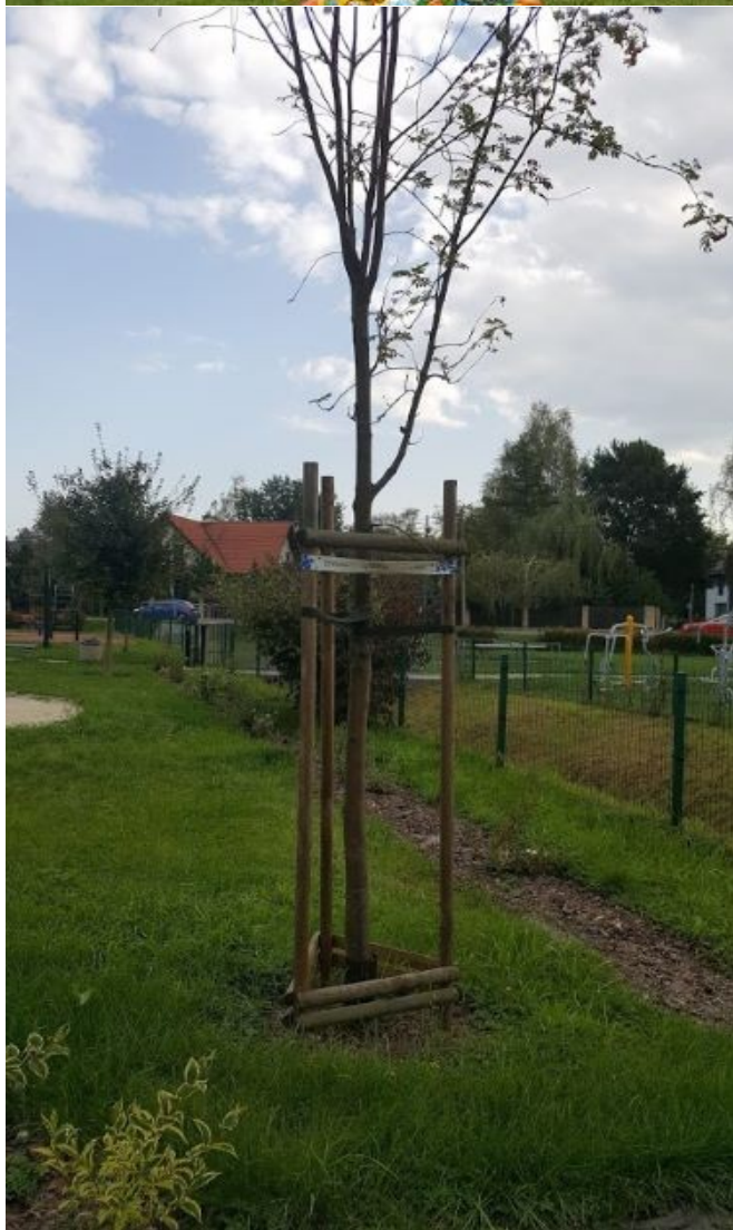
Zdjęcie nr 7 i 8 BO.D7.19/16 Budowa mini-boiska przy ulicy Jodłowej, os. Przegorzały
